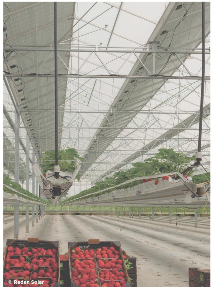
Tout est mis en œuvre pour que la luminosité soit adaptée à la culture, avec une surface minimum de clair en toiture garantissant un éclairage suffisant. La face arrière des panneaux, blanche ou transparente, contribue à garantir une luminosité minimale suffisante pour l'activité agricole. Les serres agricoles photovoltaïques présentent ainsi des rendements agricoles comparables à ceux sous serres tunnels.
