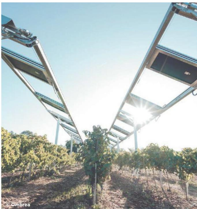
Les ombrières photovoltaïques dynamiques permettent, en fonction de l'équilibre choisi entre productions agricole et photovoltaïque, de préserver ou d'améliorer le rendement agricole par rapport à une parcelle similaire. Des recherches d'optimisation, intégrant par exemple des panneaux bifaciaux<sup>1</sup>, sont en cours.
